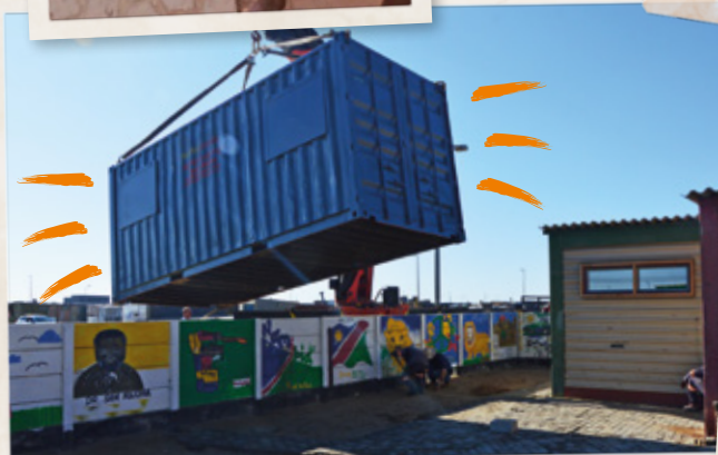
Der Container musste über die Mauer transportiert werden.
